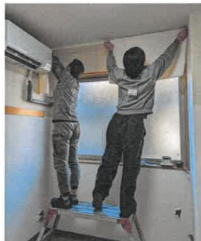
居室の壁紙の張替作業をしました
